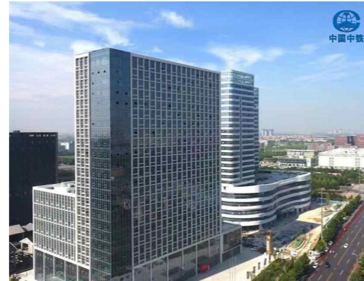
中铁广州局西北总部
