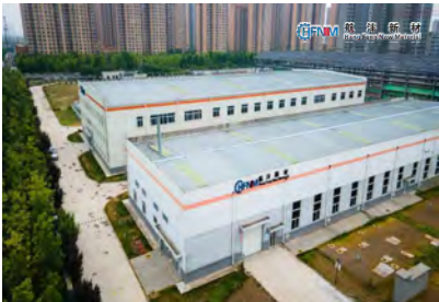
湿式碳纤维增强纸基耐磨材料产业基地
