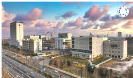
西安气象大数据应用中心
