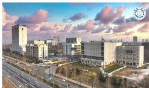
西安气象大数据应用中心
