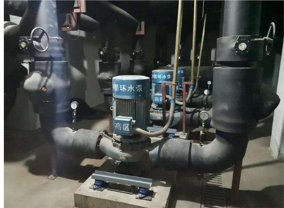
水泵基础减振
